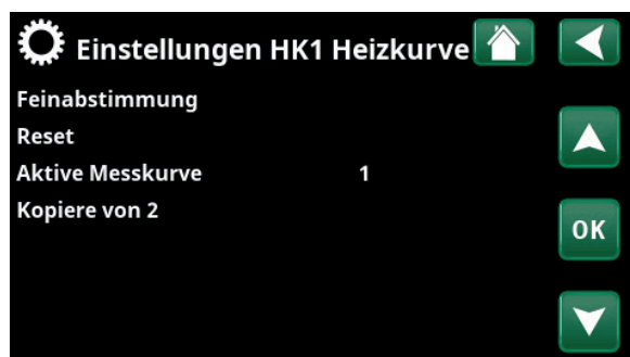
Menü „Fachmann/Einstellungen/Heizkreis/Heizkreis 1/Heizkurve“. Aktive Messkurve: #1.
